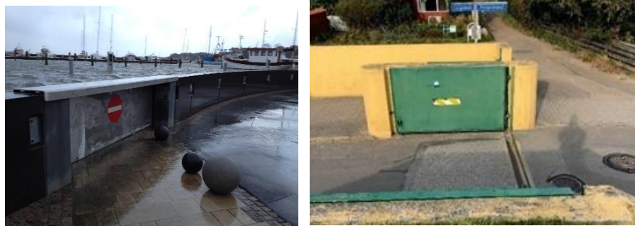
Figur 4-8 Forskellige eksempler på vandtætte port typer. Tv. Skydeport på Lemvig Havn. Th. sidehængslet svingport fra Fanø. Endelige porte udføres på flere forskellige måder.
